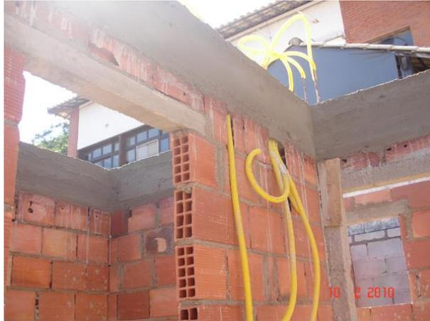
Imagem 1 - Vigas com esperas dos eletrodutos.
