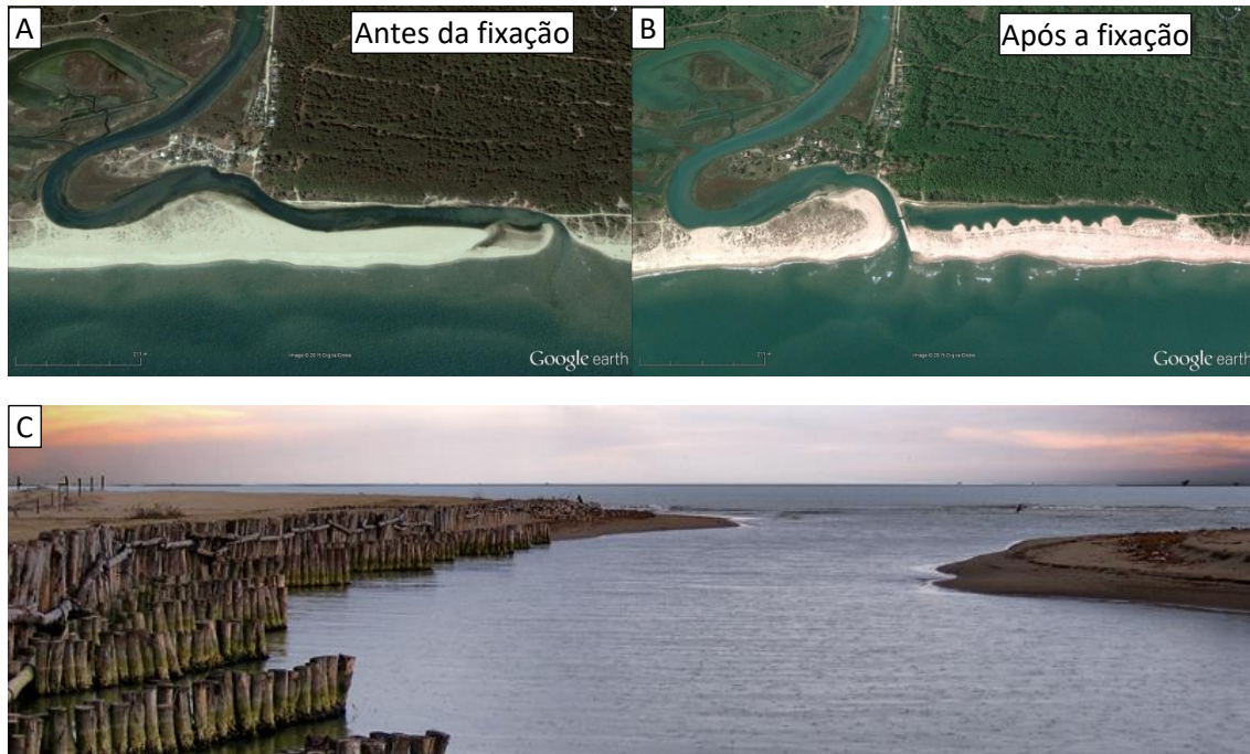
Figura 86: Modelo de fixação de barra almejado para a foz do Ri Araranguá, combinado à dragagem periódica. A) Foz do Rio Bevano sem obra de fixação em 2005 (Fonte: Google Earth); B) Foz do Rio Bevano em 2009 com a fixação da sua barra (Fonte: Google Earth); C) Detalhe da barra fixada com madeira (Foto: Alessandro Tura).
