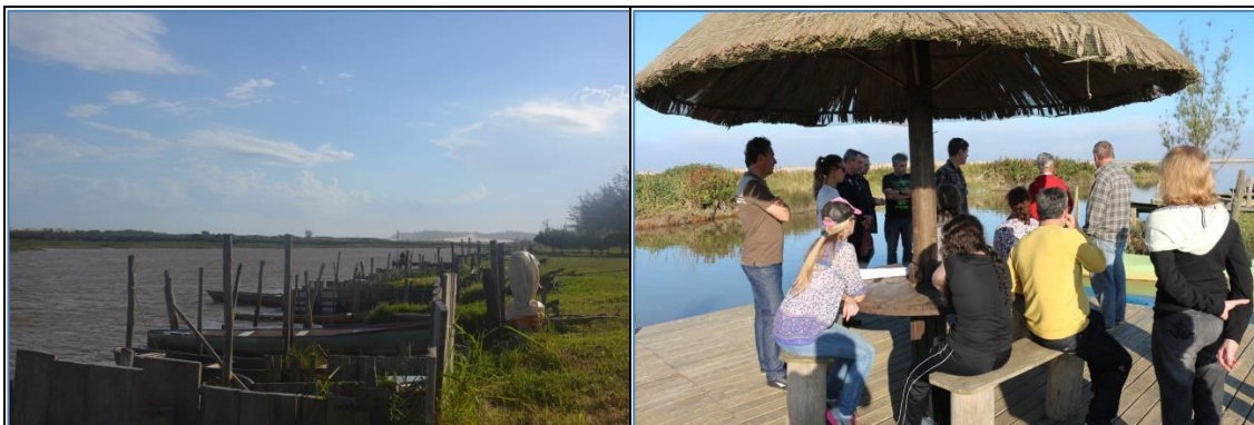
Figura 57 (trecho 3): Área de atracadouro de embarcações em Ilhas: A) Disposição desordenada de embarcações as margens do canal do Rio Araranguá (Foto: Louize Paz); e B) Construção irregular de estruturas margens do canal (Foto: Município de Araranguá).
